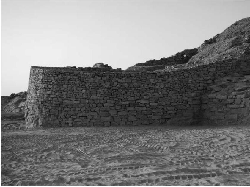
La torre che si protende verso nord ovest nella piana sottostante il sito, vista da est.
